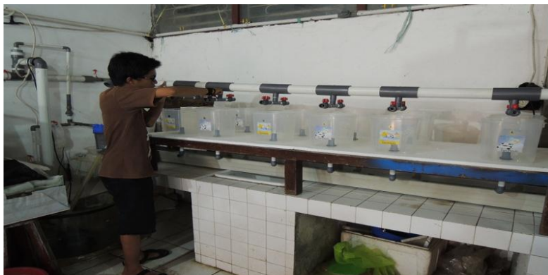
B. Pemasangan keran, pipa dan pengecekan kondisi wadah
