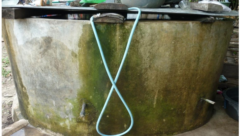
Gambar 3. Bak Penampungan Sumber Mata Air
