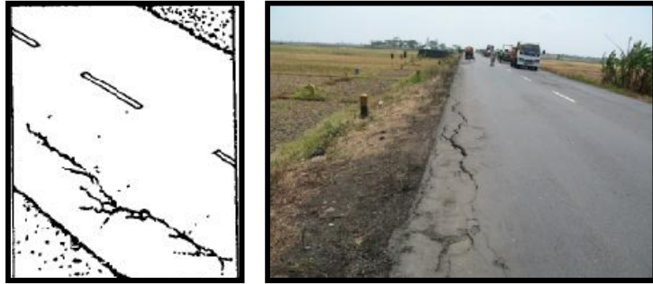
Gambar 2.5 Retak Pinggir
