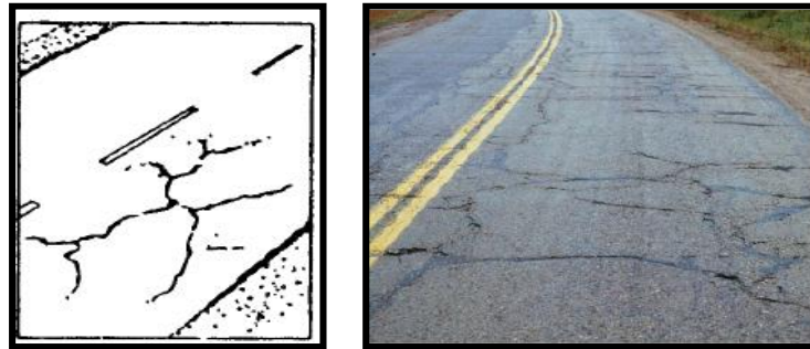
Gambar 2.10 Retak Susut
