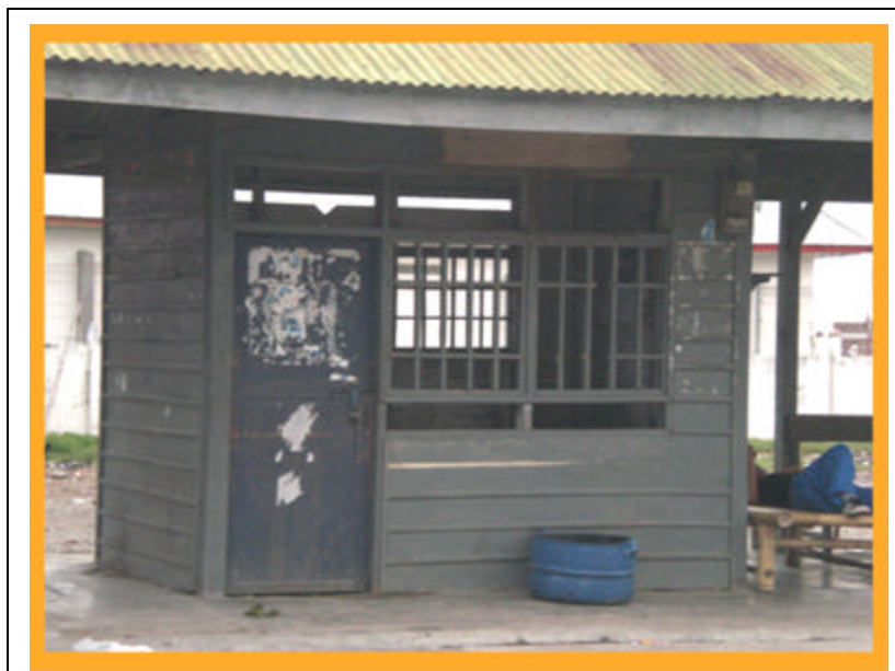
Gambar 6. Kondisi Loker Penjualan Karcis Pada Terminal Pembantu
