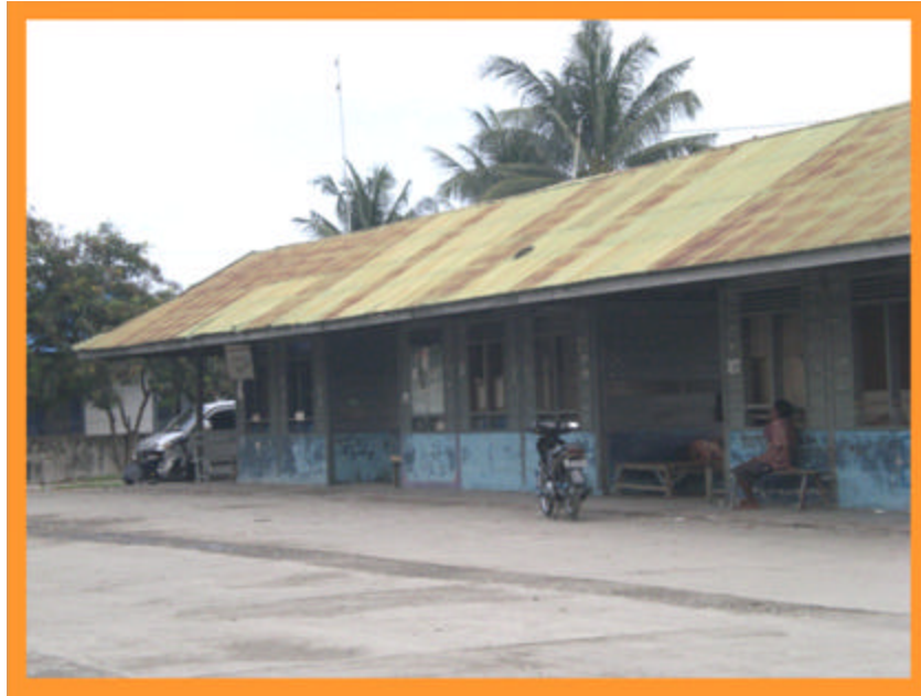
Gambar 5. Situasi Loker Penjualan Karcis dan Ruang Tunggu Pada Terminal Pembantu
