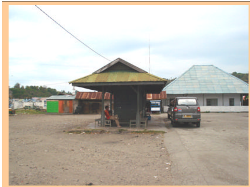
Gambar 13. Kondisi Fasilitas dan Lingkungan di dalam Terminal
