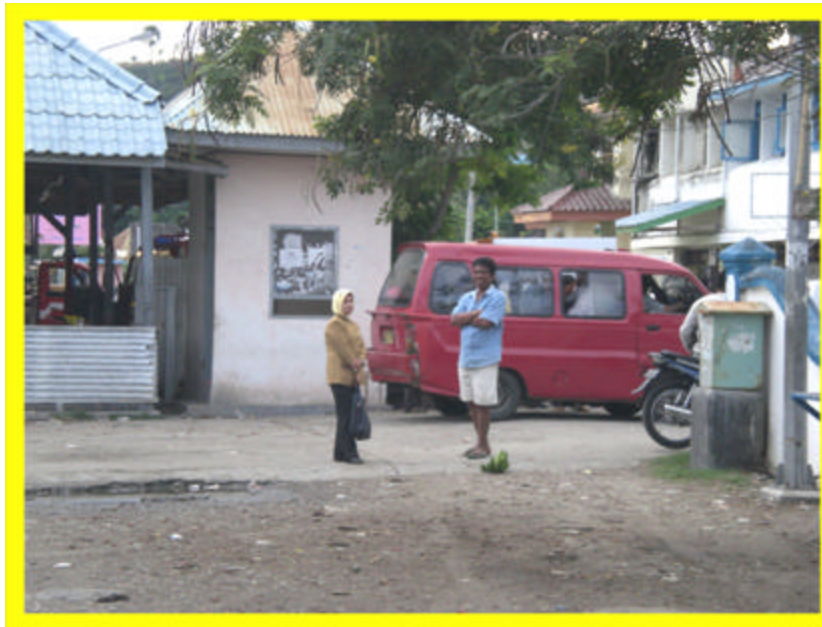
Gambar 12. Kondisi Sarana Pos Jaga Pada Terminal Pembantu di Kota Majene
