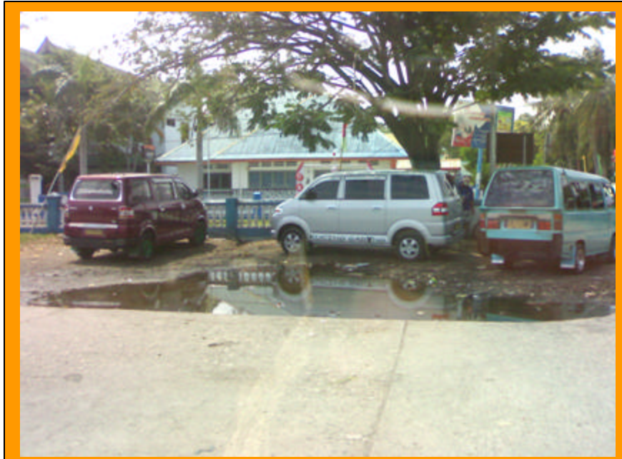
Gambar 15. Kondisi Fasilitas dan Lingkungan di dalam Terminal
