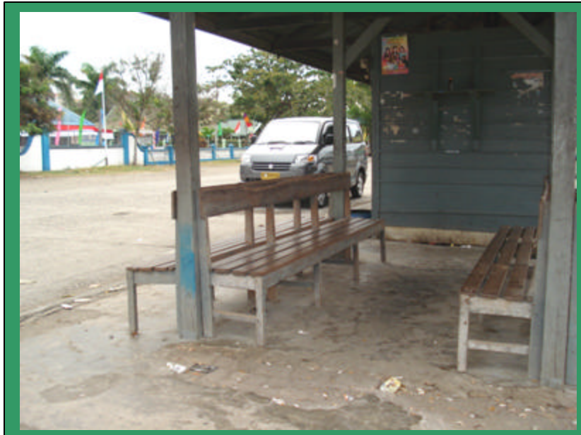
Gambar 9. Kondisi Ruang Tunggu Pada Terminal Pembantu di Kota Majene
