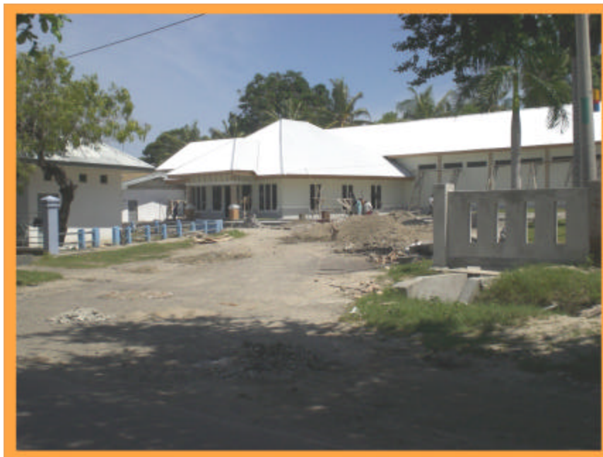
Gambar 2. Kondisi Terminal Utama yang Sedang Dalam Tahap Renovasi
