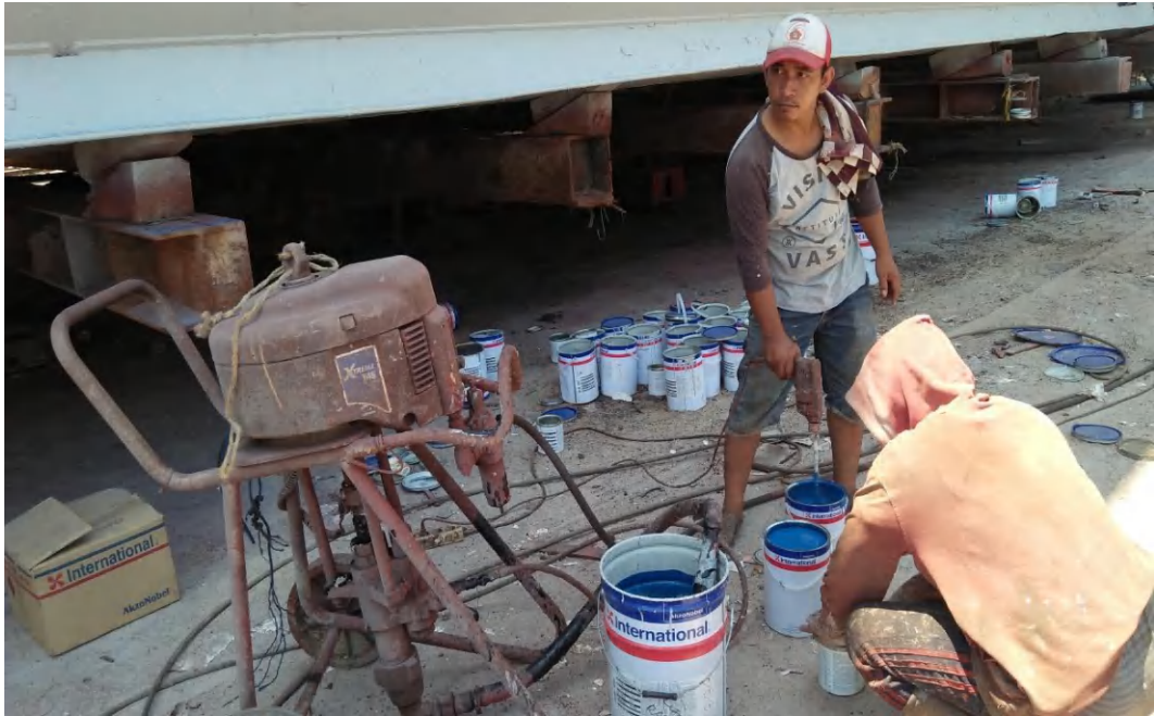
Proses pencampuran cat dengan menggunakan mixer dan airless
