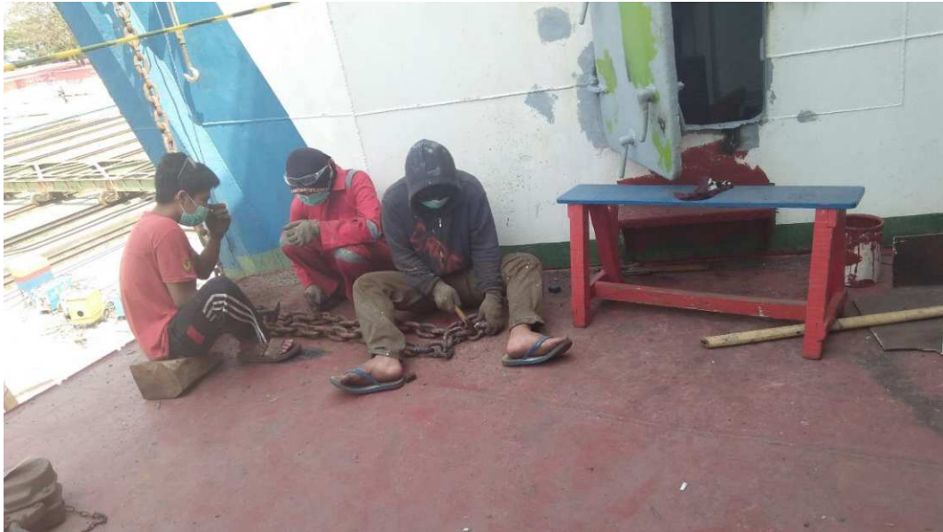
Proses pengerjaan Palu-palu pada rantai kapal
