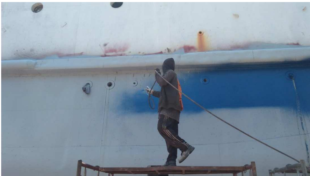
Proses pengecatan dengan menggunakan mesin airless
