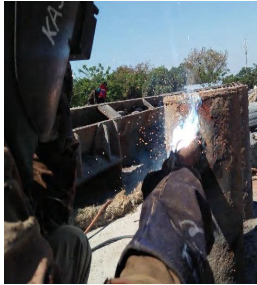
Pengerjaan Brender pada lambung kapal dan bollard
