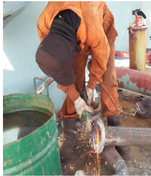
Proses pengerjaan Gurinda pada pipa di main deck
