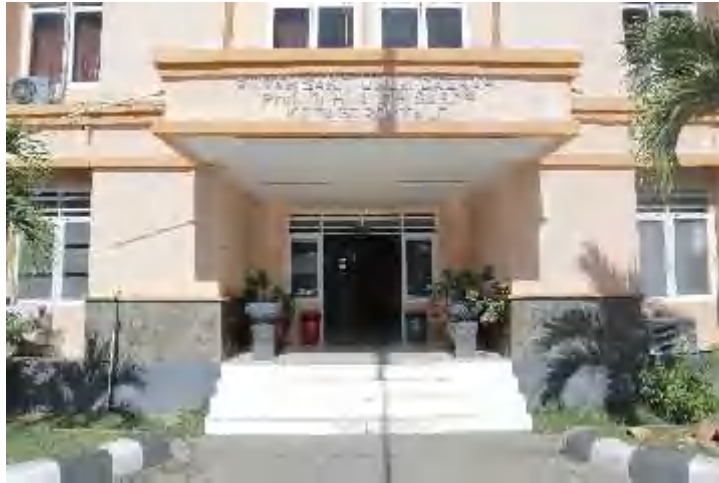
Tampak Depan Wilayah Bagian Kantor (Berhadapan dengan Lapangan Upacara)
