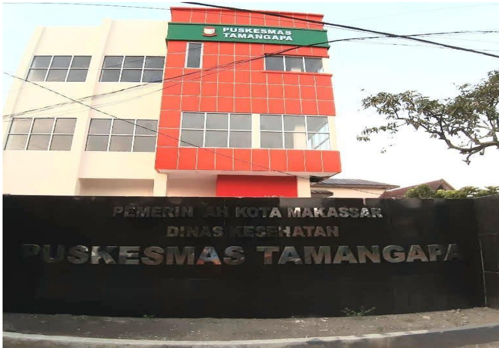
Foto Bangunan Puskesmas Tamangapa Kota Makassar
