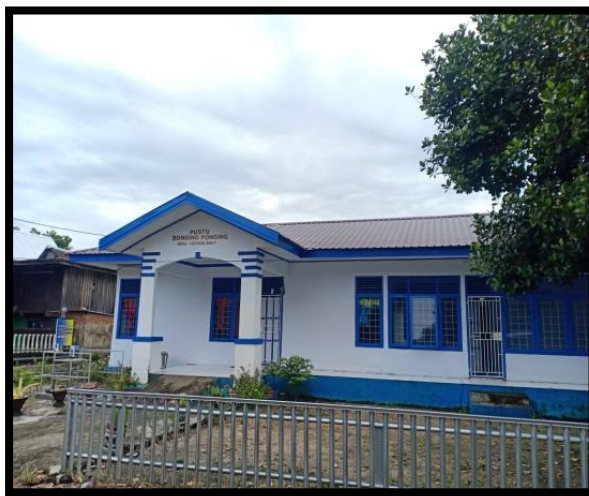
Gambar 25. Kondisi Sarana Kesehatan PUSTUS
