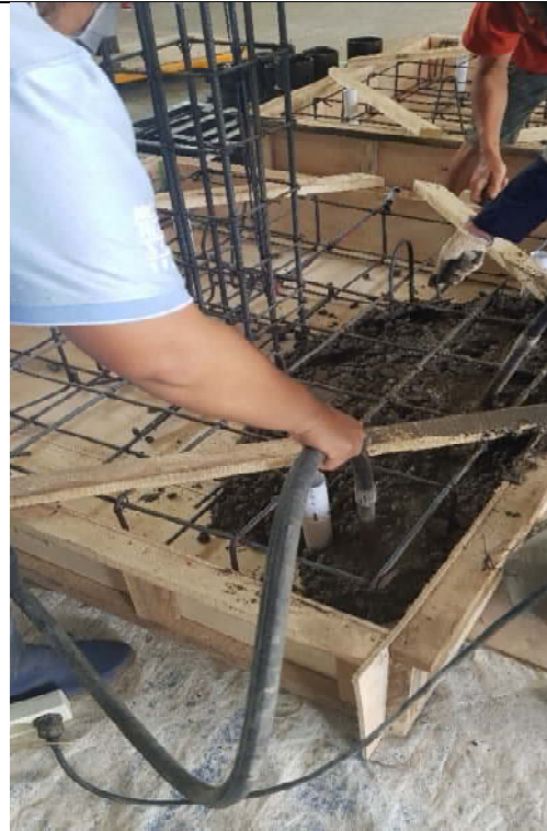
Pemadatan Adukan Beton
