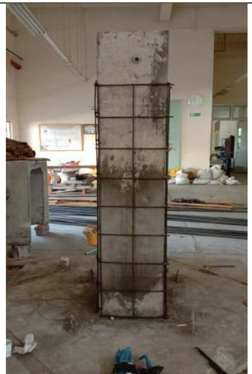
Pemasangan tulangan wire mesh
