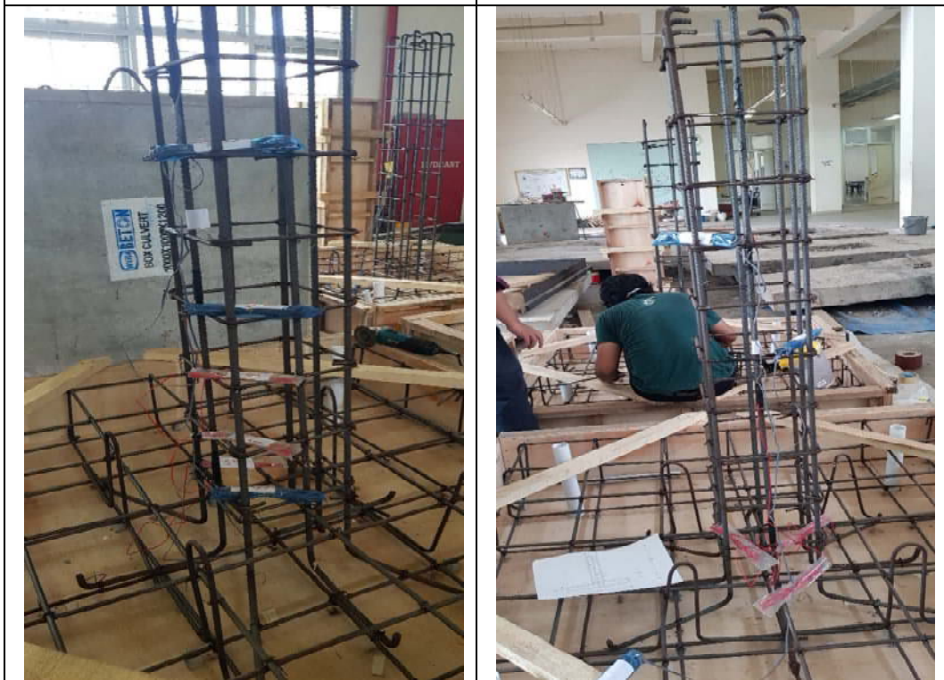
Pemasangan Strain Gauge
