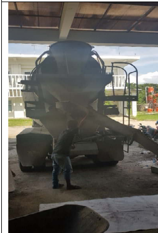
Mobilisasi Adukan Beton
