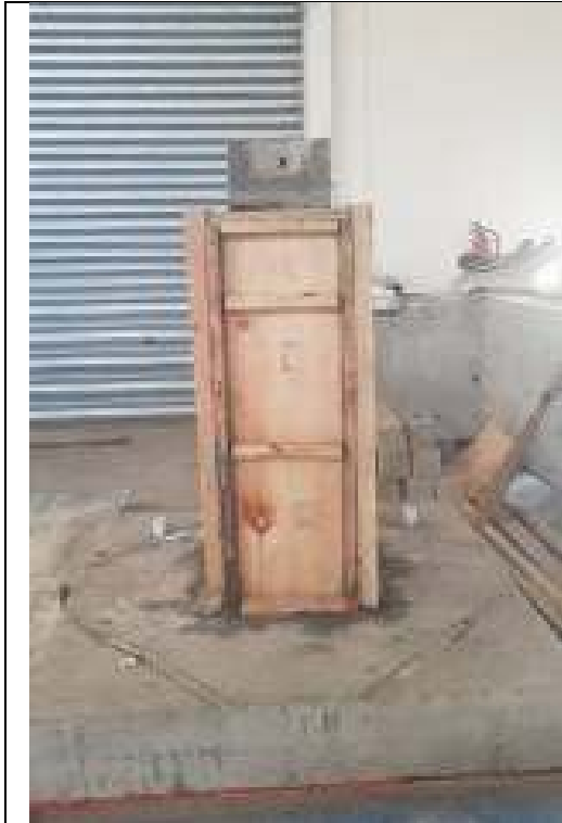
Pemasangan bekesting retrofit
