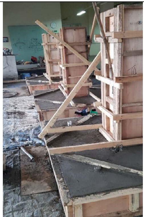
Pengecoran kolom
