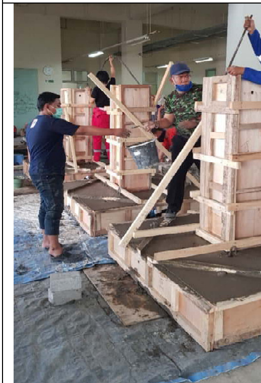
Pengecoran kolom
