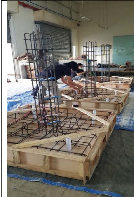
Persiapan Pengecoran
