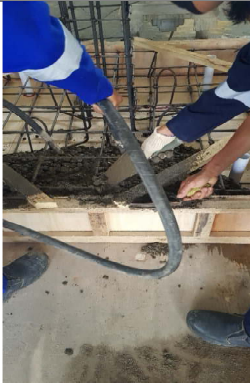
Pengecoran Spesimen
