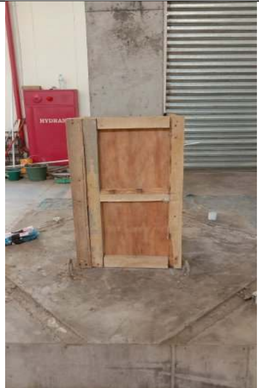
Pemasangan bekesting retrofit
