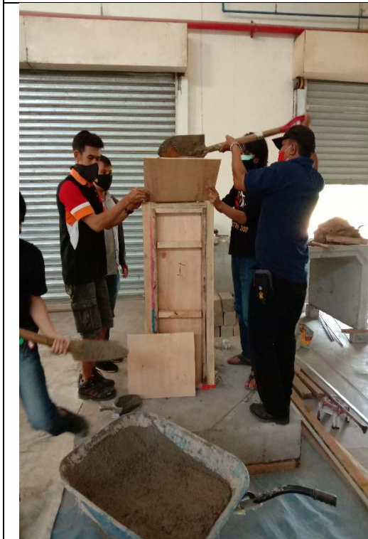
Pengecoran retrofit
