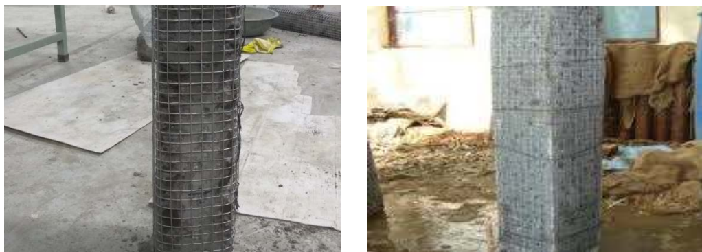
Gambar 7. Contoh metode ferrocement laminate jacketing pada kolom
