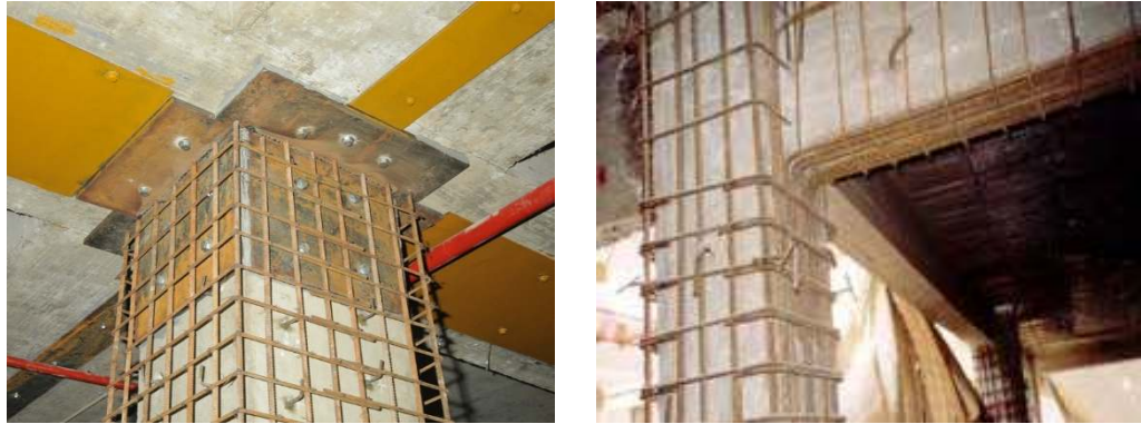
Gambar 1. Contoh metode concrete jacketing pada kolom
