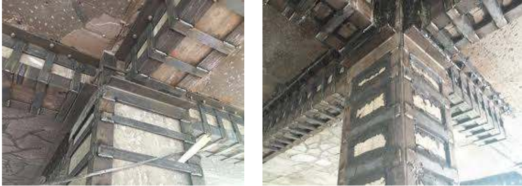
Gambar 3. Contoh metode steel jacketing pada kolom
