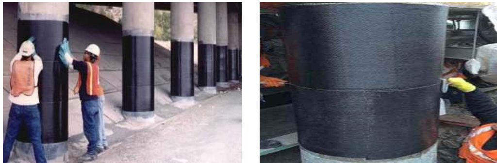
Gambar 6. Contoh metode Fiber Reinforced Polymer jacketing pada kolom
