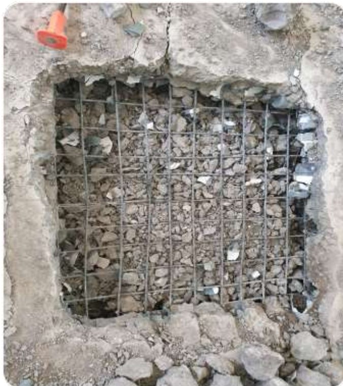
Gambar 57. Pembongkaran pada Pelat Pejal (PP-1)
