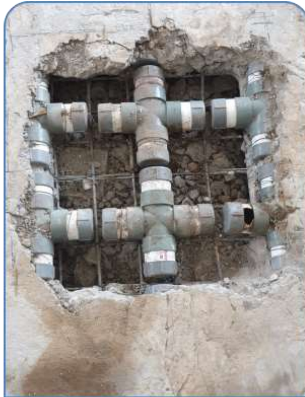
Gambar 61. Pembongkaran pada Pelat Berongga (PB-3)
