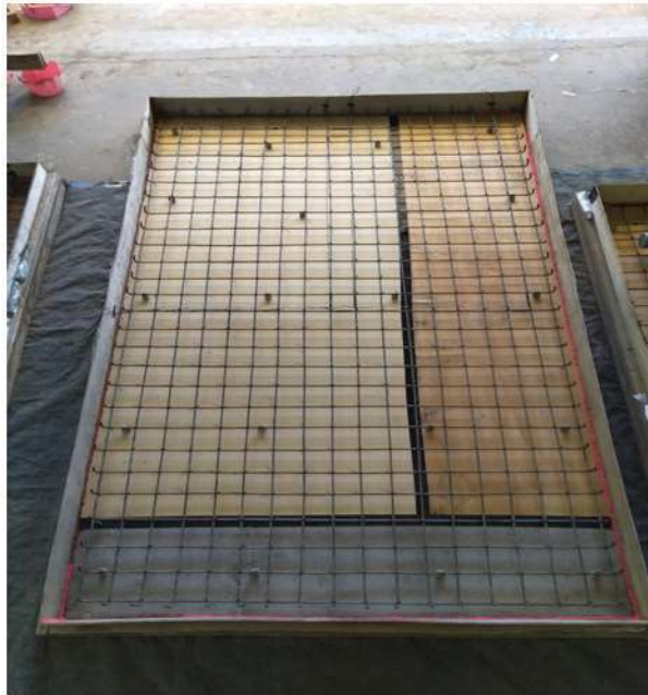
Gambar 28. Pembesian dan Bekisting Pelat
