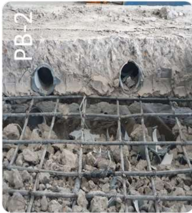
Gambar 62. Rongga yang Tidak Berubah Bentuk pada PB-2
