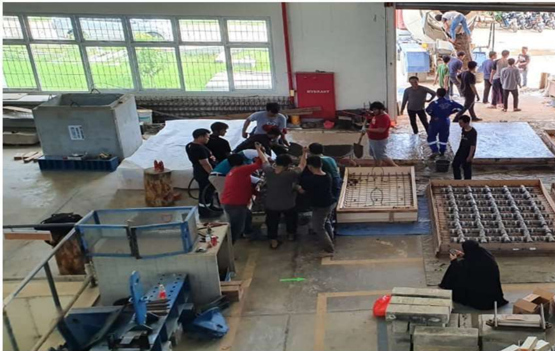
Gambar 37. Pengecoran pada Pelat Uji
