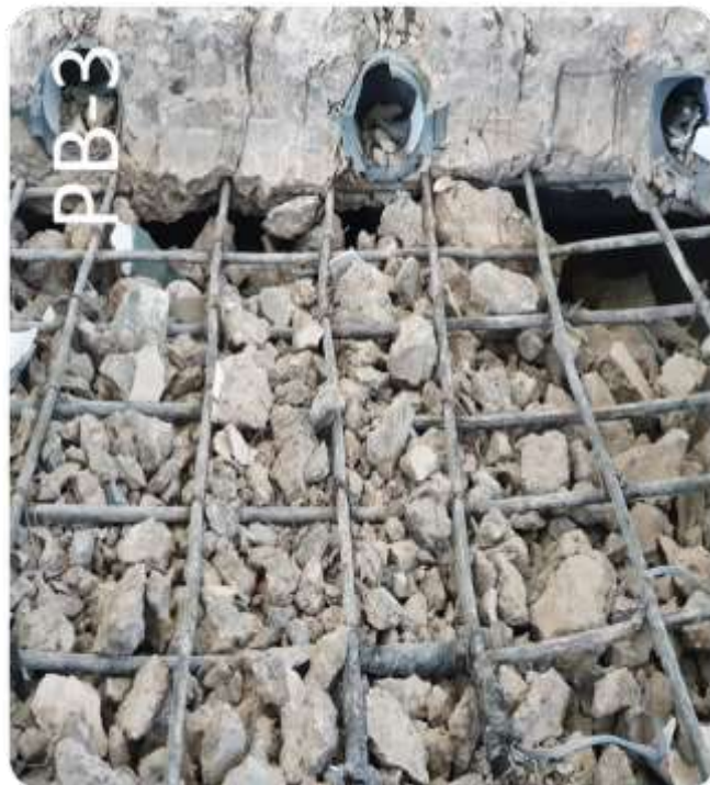
Gambar 63. Rongga yang Tidak Berubah Bentuk pada PB-3
