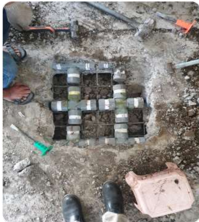
Gambar 59. Pembongkaran pada Pelat Berongga (PB-2)
