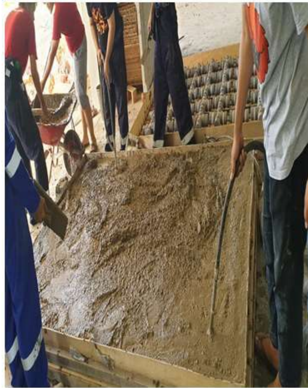
Gambar 36. Pengecoran pada Pelat Uji
