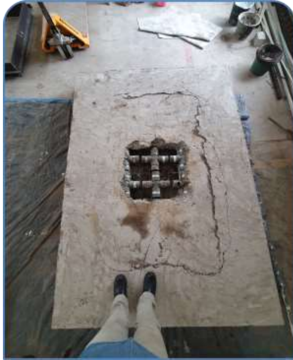
Gambar 60. Pembongkaran pada Pelat Berongga (PB-3)
