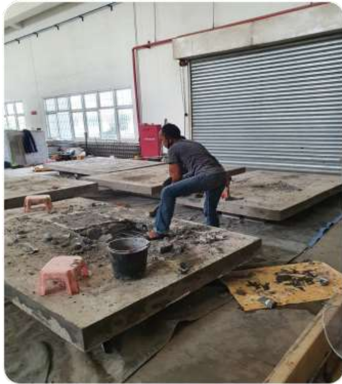
Gambar 56. Pembongkaran pada Pelat Pejal (PP-1)
