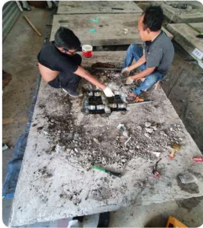
Gambar 58. Pembongkaran pada Pelat Berongga (PB-2)
