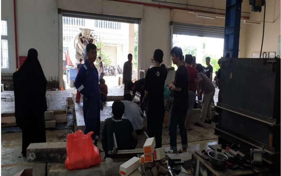
Gambar 38. Pengecoran pada Pelat Uji
