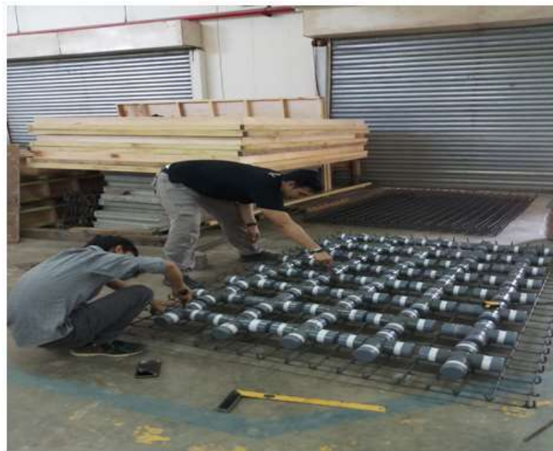
Gambar 31. Rangkaian Rongga pada Pelat
