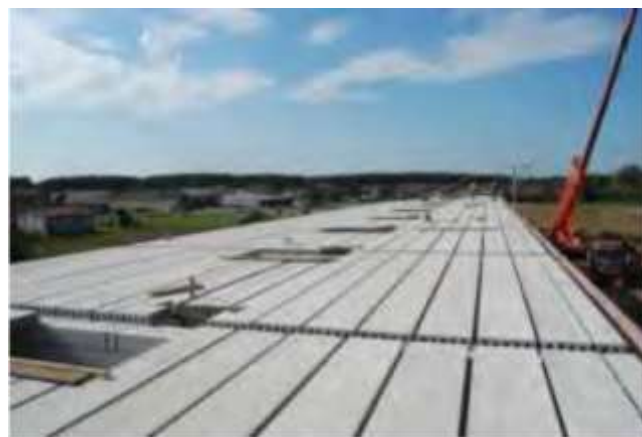
Gambar 12. Konstruksi Gedung Dengan Pelat HCS
