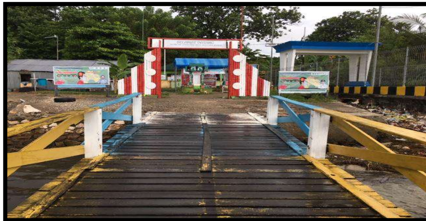
Gambar 20. Kondisi Dermaga Pulau Sabutung
