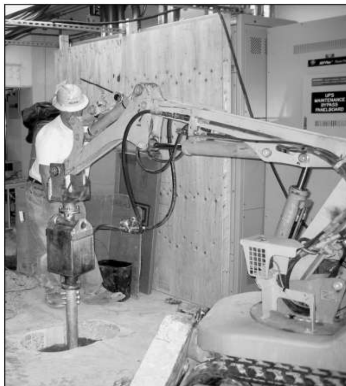
4 Instalasi tiang helix pada akses area yang terbatas (milik Earth contact products, Inc.)
