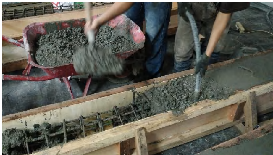
Penuangan Campuran Beton ke Bekisting dan Penggunaan Vibrator pada Campuran Beton
