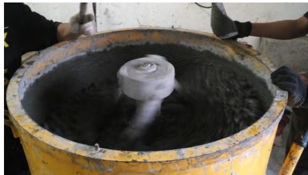
Mix Campuran Beton Menggunakan Concrete Mixer
