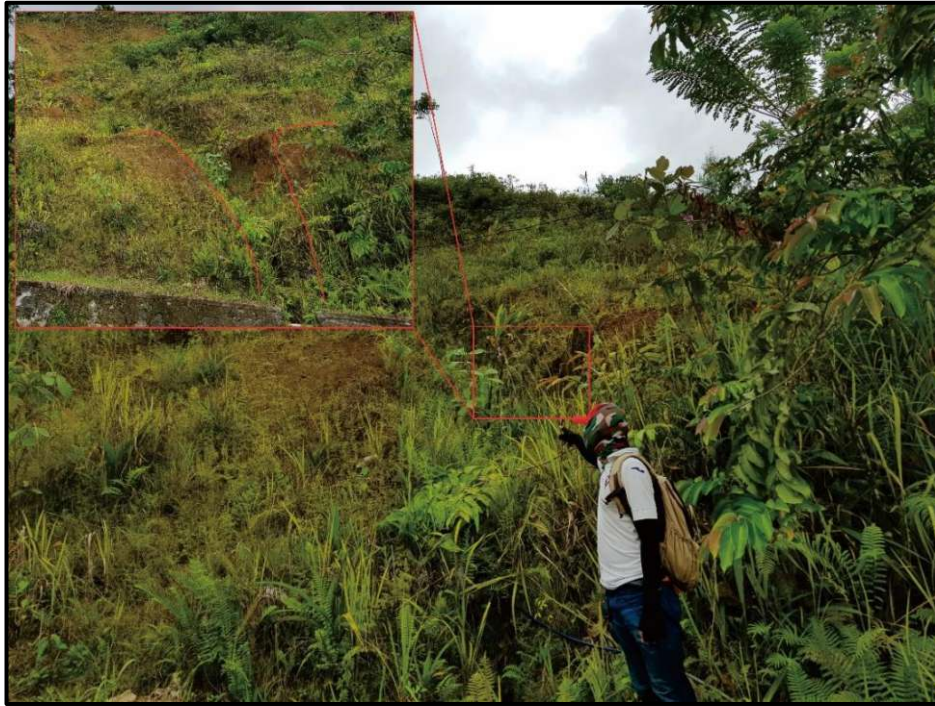
Gambar 2.4 Gully erosion pada daerah Tampak Kurra dengan arah foto N 303° E
