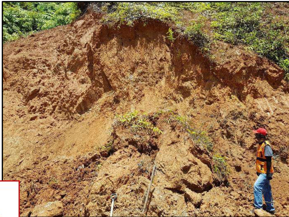
Gambar 2.5 Debris fall pada stasiun 18 dengan arah foto N 305°E
