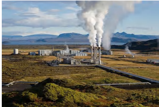
Gambar 2.7 Pembangkit Listrik Tenaga Panas Bumi Sumber: www.kabar5.com
