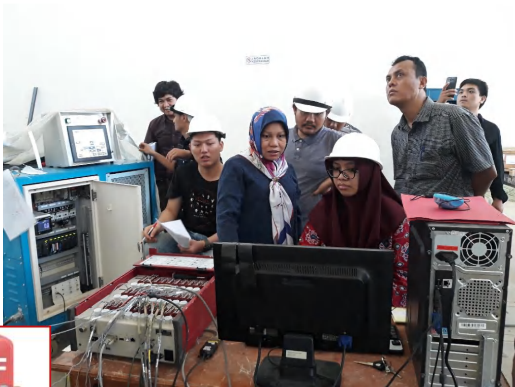
Pemasangan Peralatan Pengujian
