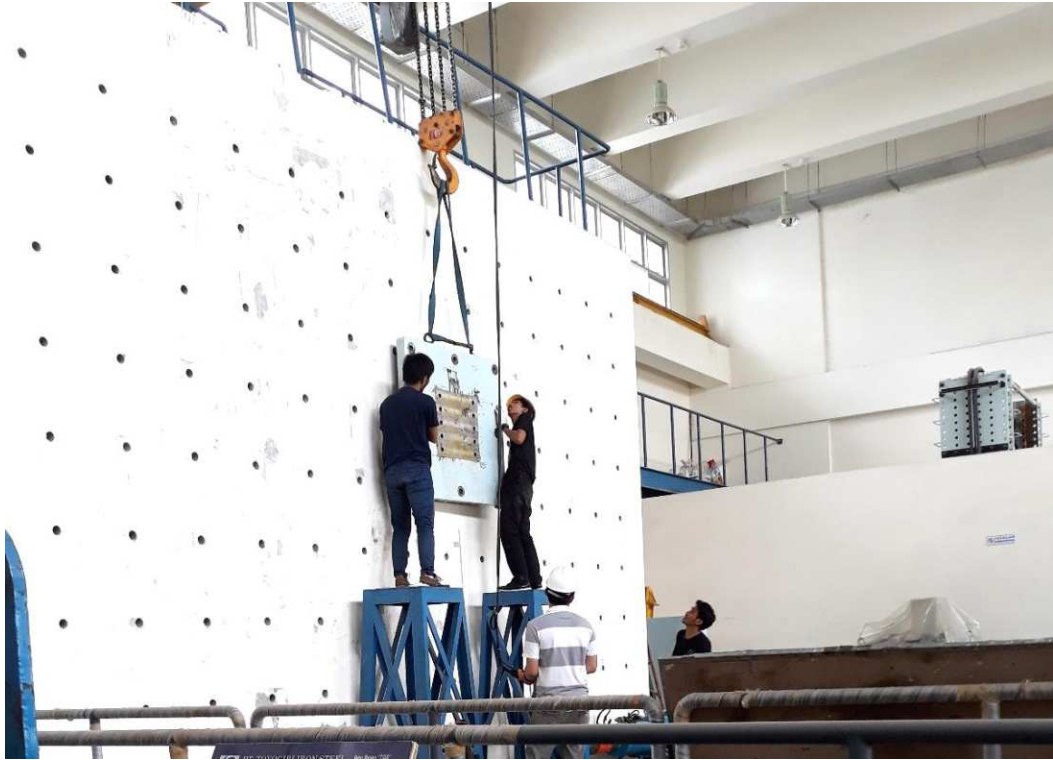
Pemasangan Landasan Actuator ke Strong Wall
