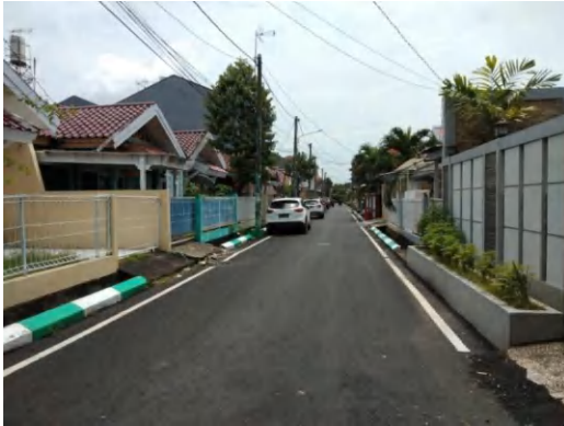
Gambar 25. Kondisi lingkungan di RT 01 RW 02 Kelurahan Pandang
