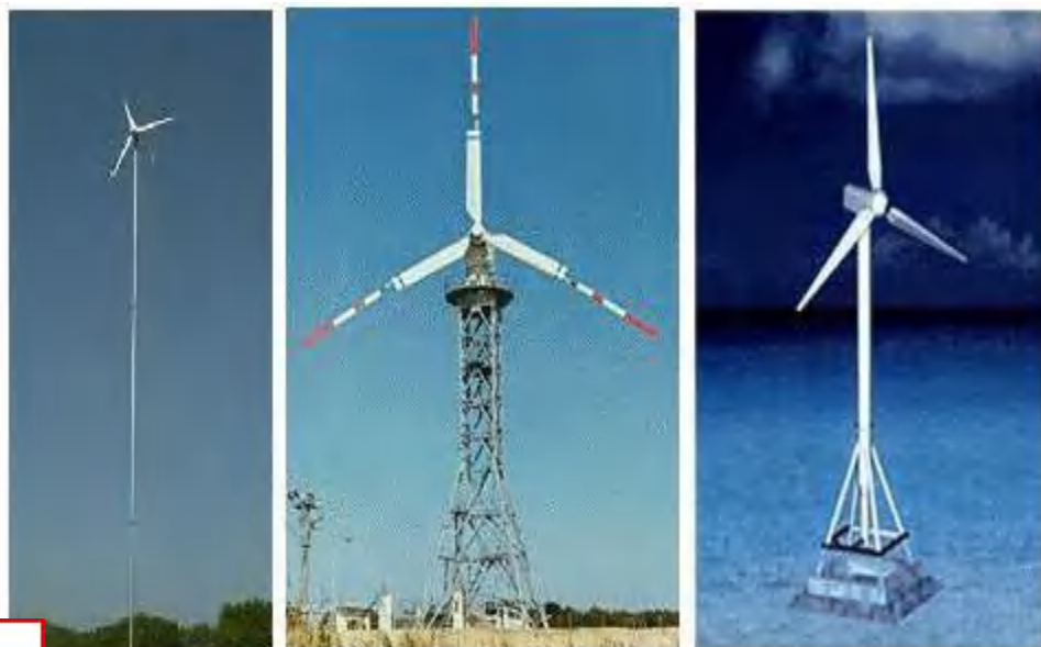
Gambar 2.8 Tower PLTB (kiri), guyed (tengah), lattice (kanan), monostructure[6]
