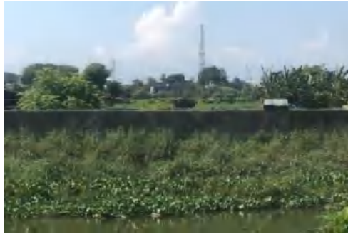
(1) Kondisi Sungai Pampang segmen 1
