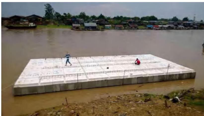
**Gambar 2. 26** Rumah Apung dengan Platform Styrofoam
