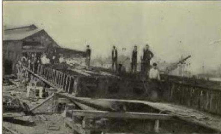
*Gambar 5 Perakitan Struktur Double Bottom
