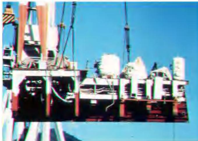
*Gambar 15 Blok/Modul Kamar Mesin yang Dikerjakan Secara On-Unit Outfitting Dengan Integrasi Pekerjaan Pengecatan
