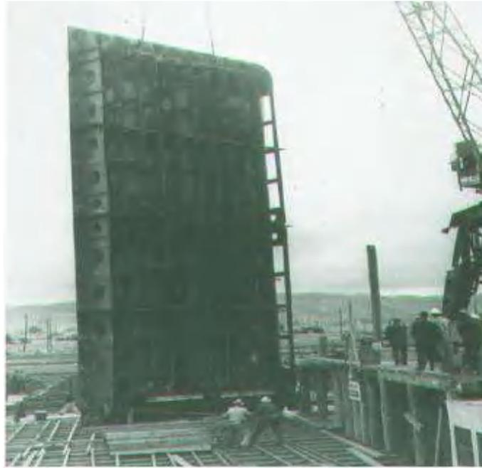
Gambar 9 Pembuatan Kapal Menggunakan Sistem Seksi
