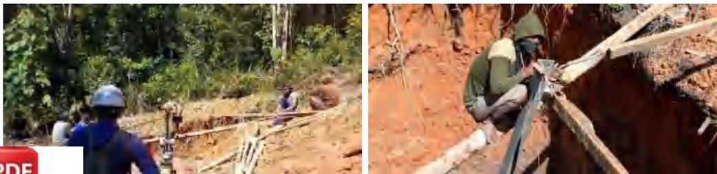
**Gambar 22.** *Stub setting* yang dilakukan pekerja instalasi menara SUTT
