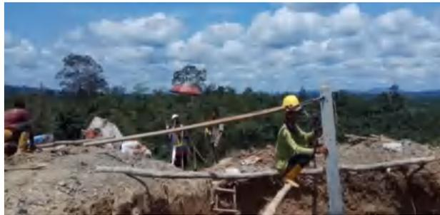
**Gambar 1.** *Setting stub* yang dilakukan oleh pekerja instalasi *tower* SUTT
