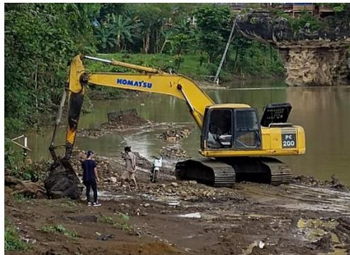
Gambar 3.3 Proses pengerukan pasir
