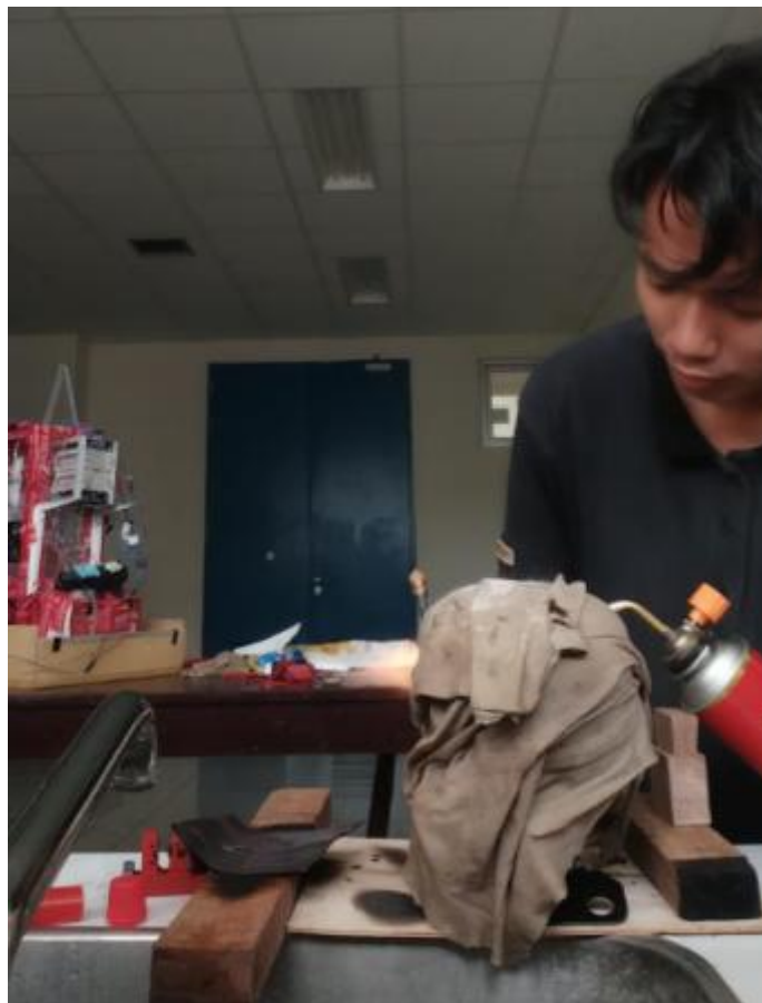
Dokumentasi proses pengelasan pipa tembaga
