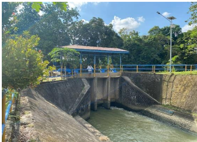
Gambar 2. Bangunan Utama. (Sumber: Data Primer, 2023).
