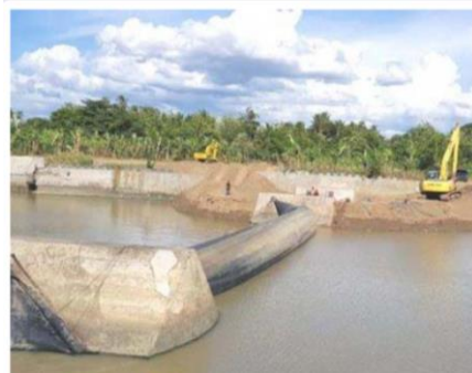
Gambar 5. Bendung Karet. (Sumber: Ditjen SDA).
