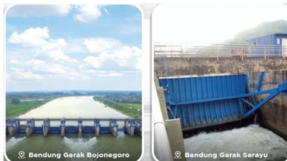
Gambar 4. Bendung Gerak Vertikal. (Sumber: Kementerian PUPR, 2021).
