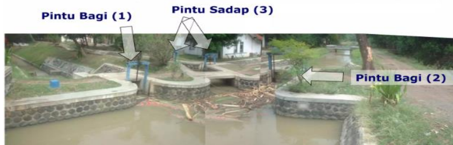
Gambar 8. Bangunan Bagi dan Sadap. (Sumber :Ars, 2016).
