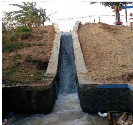
Gambar 7. Bangunan Got Miring. (Sumber: Ulfiana, 2016).
