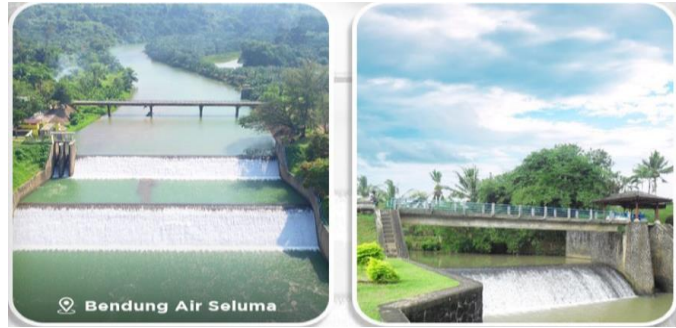
Gambar 3. Bendung Tetap. (Sumber: Kementerian PUPR, 2021).
