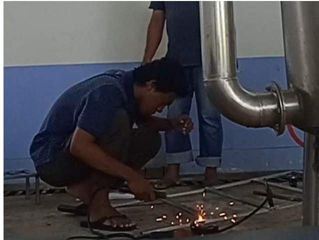
Lampiran 5 Perakitan rangka untuk dudukan panel surya
