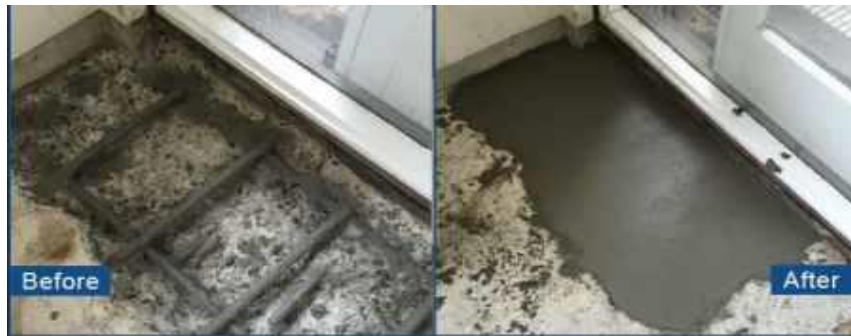
Gambar 23 Perbaikan dan finishing dengan material Grouting
