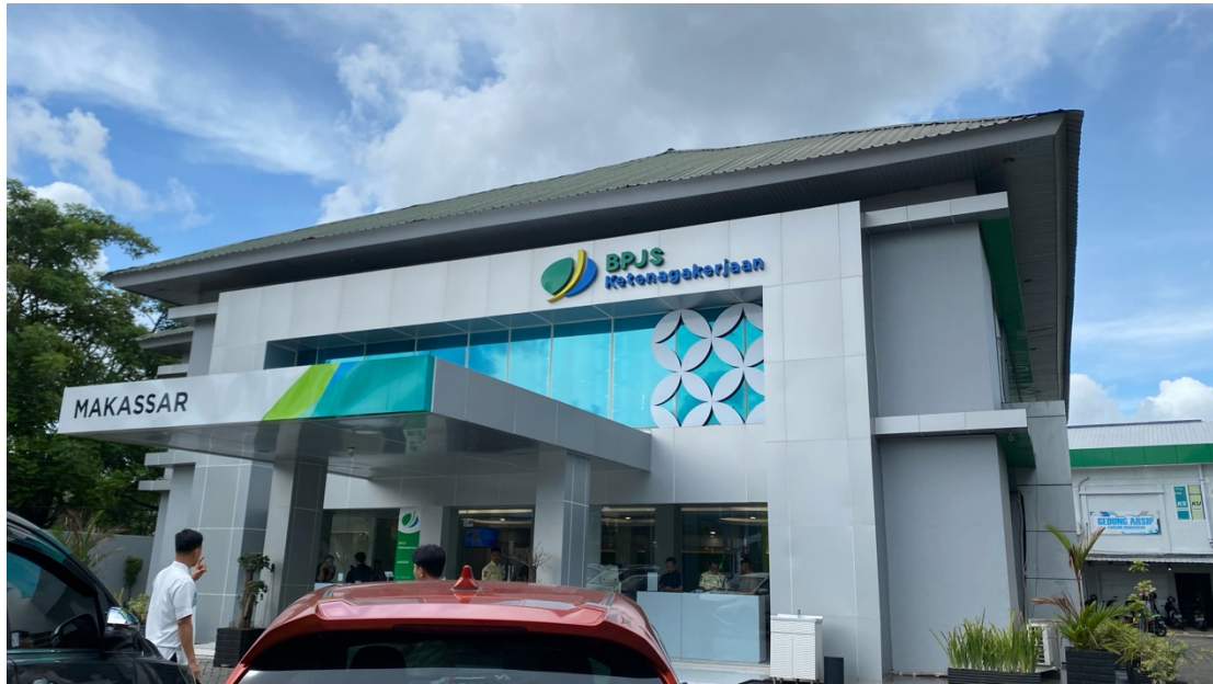
Kantor BPJS Ketenagakerjaan Makassar
