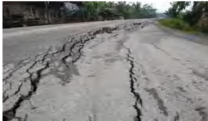
Gambar 2. 3 Retakan jalan
