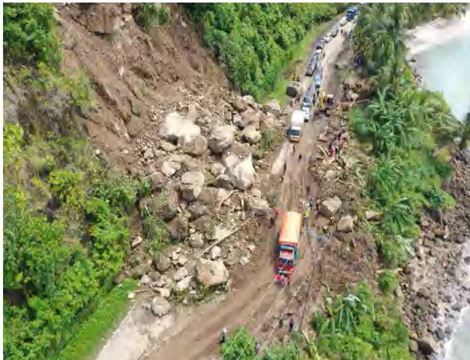
Gambar 7. Kejadian Longsor Desa Onang Utara
