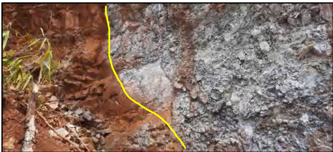
Gambar 14 Hasil pelapukan kimia pada stasiun 9 sebagai bentuk pengaruh oksidasi pada batuan dengan arah pengambilan foto N 258° E
