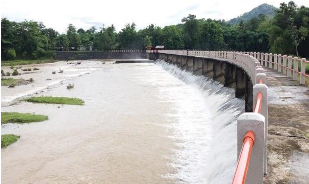
Air baku Bendung Lekopancing
