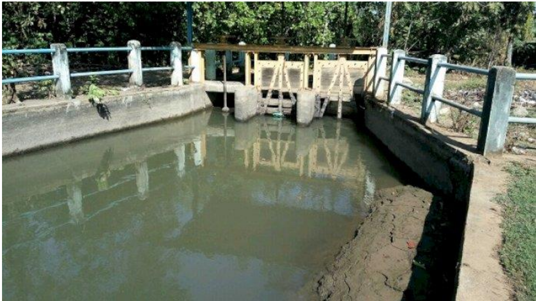
Kanal Bendung Lekopancing
