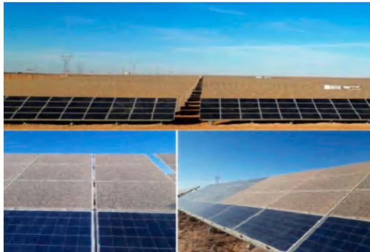
**Gambar 5** Akumulasi Debu pada Modul PV (Nezamisavojbolaghi *et al.*, 2023)
