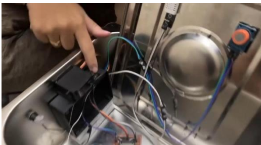
Pemasangan switch on off
