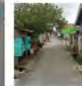
A Kondisi Drainase tersier yang mengalir langsung ke drainase Utama
