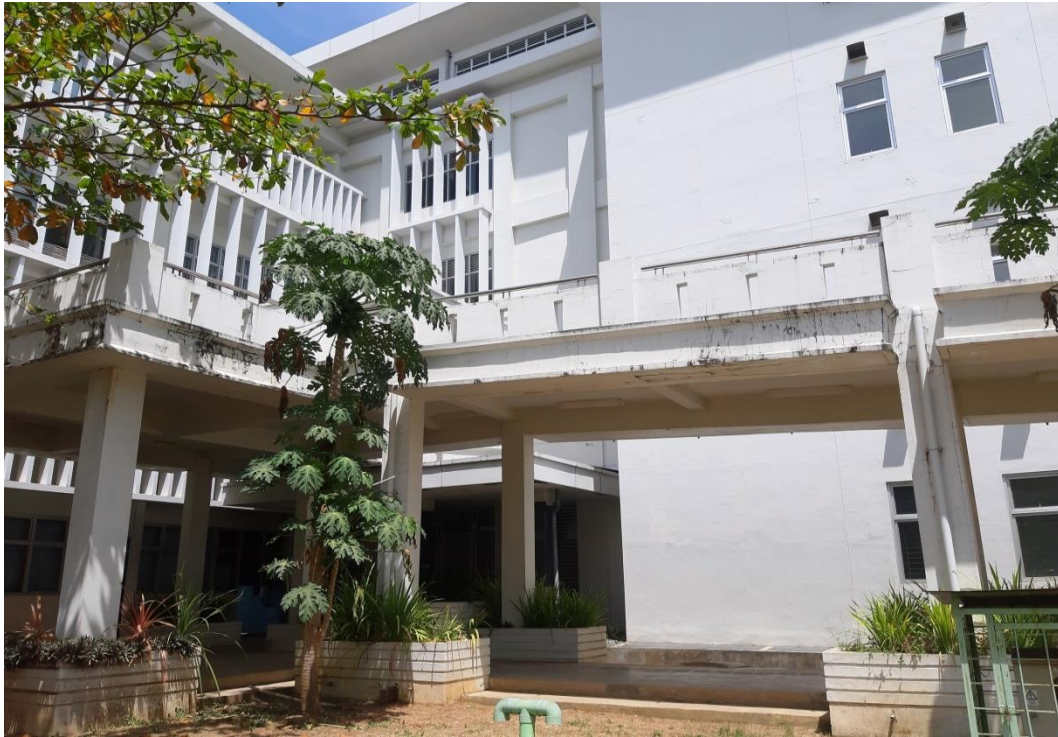
(d) Jembatan penghubung Departemen Teknik Elektro Unhas, Gowa.
