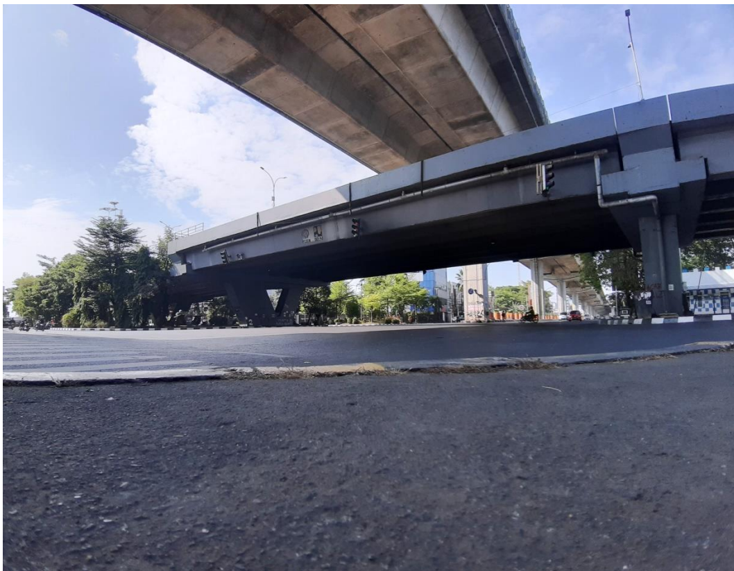
(a) Jembatan Layang Urip Sumoharjo
