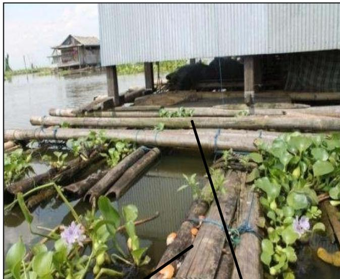
Gambar 4 Struktur lapisan bambu pada rakit di rumah mengapung
