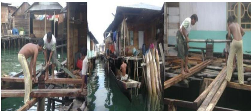
Gambar 14 Penempatan balok penyangga ruas (Balok Angsale)
