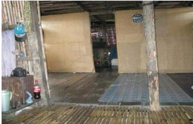
Gambar 10 Struktur lantai papan dan bambu pada rumah mengapung
