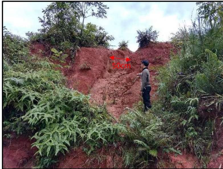
Gambar 13 Rill erosion pada stasiun 62 Daerah Tagari dengan arah pengambilan foto N 108°E
