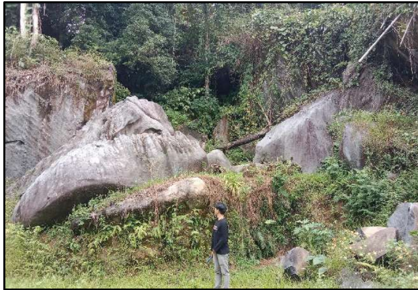
Gambar 16 Rock fall pada stasiun 83 dengan arah pengambilan foto N 48°E
