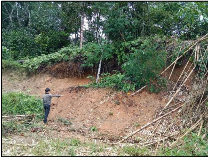
Gambar 14 Debris Slide pada stasiun 60 dengan arah pengambilan foto N 12°E
