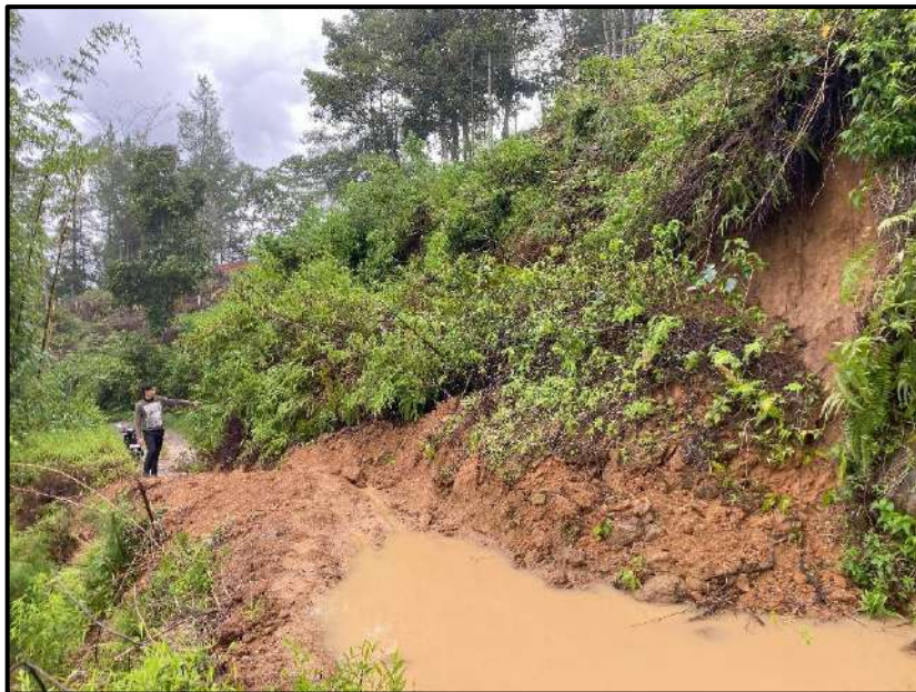
Gambar 15 Debris fall pada stasiun 55 dengan arah pengambilan foto N 15°E
