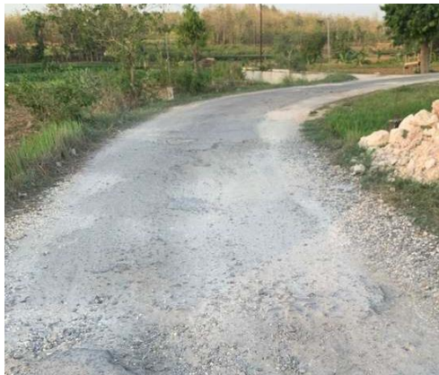
c) akses jalan menuju Waduk Tempuran
