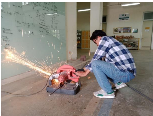
Lampiran 3. Pembuatan Tulangan Baja dan Persiapan Tulangan Spiral
