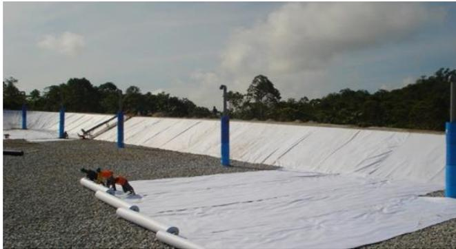
Gambar 4. Pemasangan linier geosintetis
