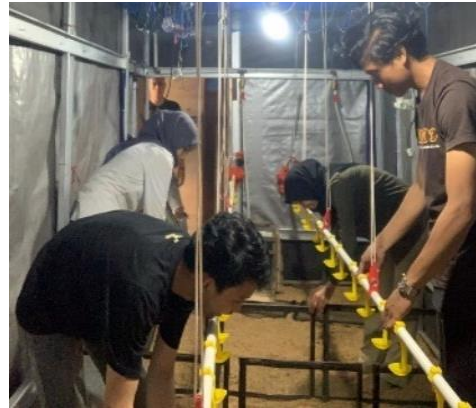
Ket. Pemasangan Sekat
