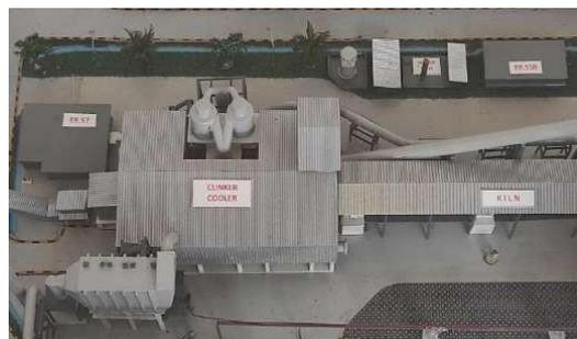
Gambar 1 *Clinker cooler* PT. Semen Tonasa Unit V. Sumber: Anindhitya, 2023
