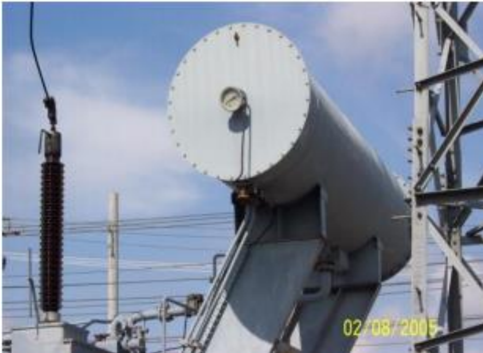
Gambar 9 Konservator minyak (tangki) Sumber: (Siburian, 2019)
