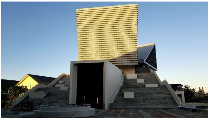
Gambar 1. Gedung Perpustakaan Universitas Islam Makassar
