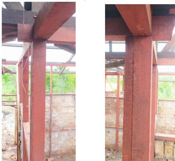
Gambar 2.10 Kolom rangka kayu pada Rumah Kancingan
