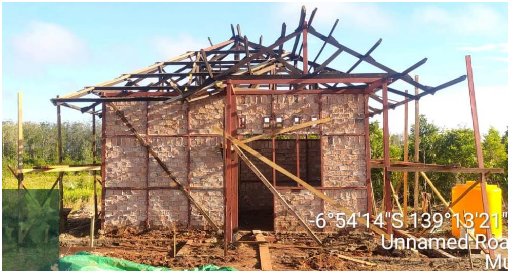
Gambar 2. 1 Proses Pembangunan Rumah Kancingan
