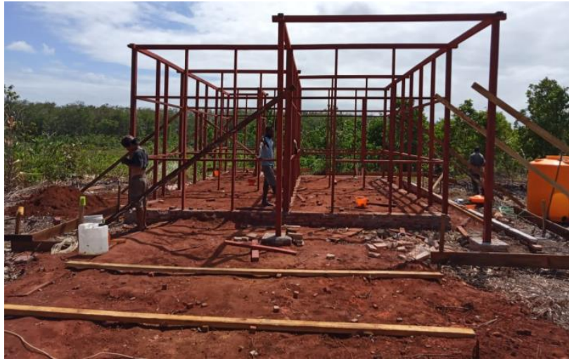
Gambar 2.9 Kolom rangka kayu pada Rumah Kancingan
