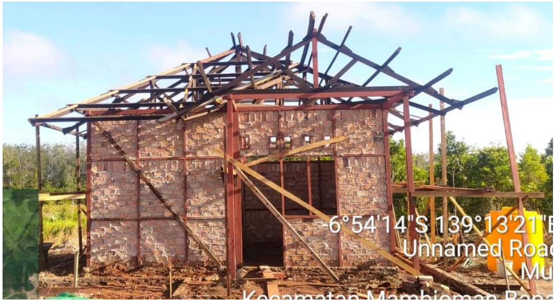
Gambar 2.11 Konstruksi kuda-kuda pada Rumah Kancingan
