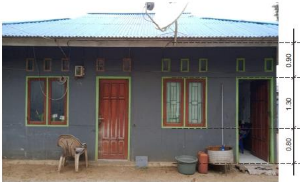
Gambar 2. 16 Pola balok melintang pada Rumah Kancingan
