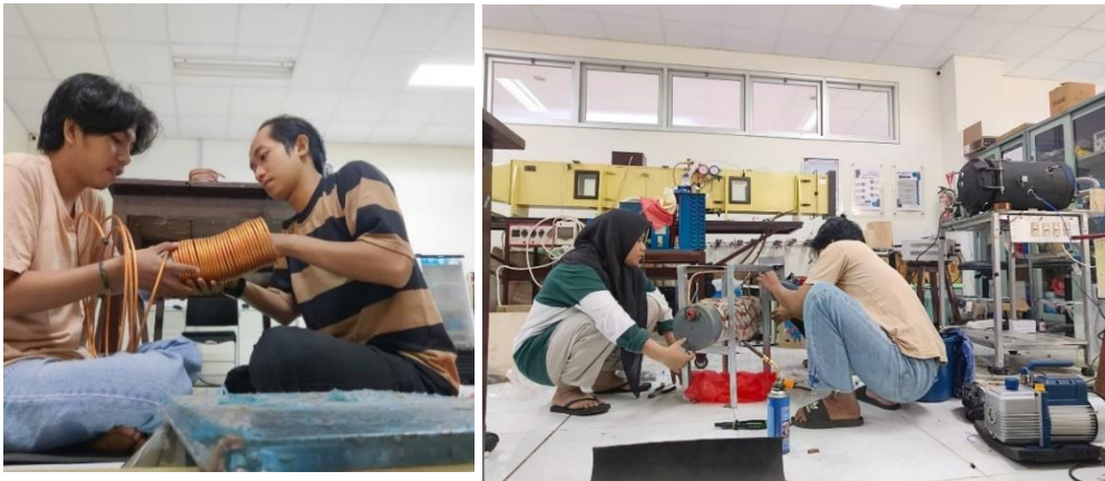
Gambar 60 Pembuatan dan Pemasangan Kondensor
