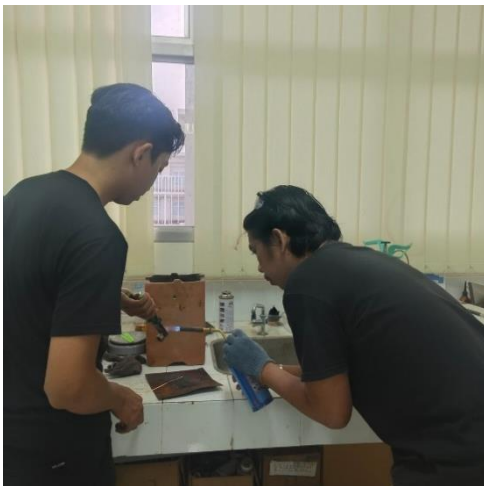
Gambar 59 Pemasangan dan Pengelasan Sambungan Pipa Tembaga
