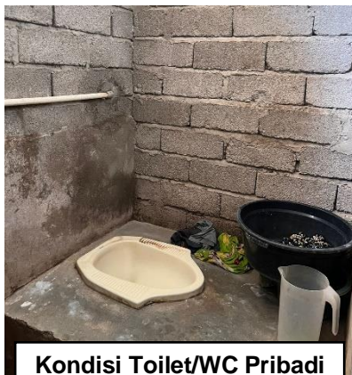
Kondisi Toilet/WC Pribadi di Desa Kalora
